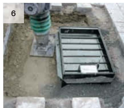
Riempimento e calcestruzzo.
