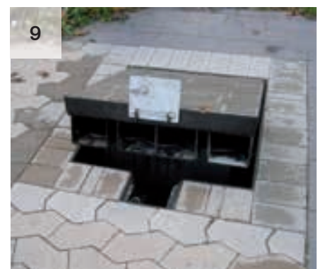
Riempimento della copertura.
