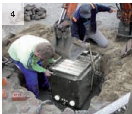
Inserimento del Campetto nello scavo preparato
