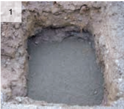
Lavori di scavo.
