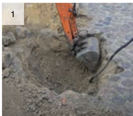
Lavori di scavo.
