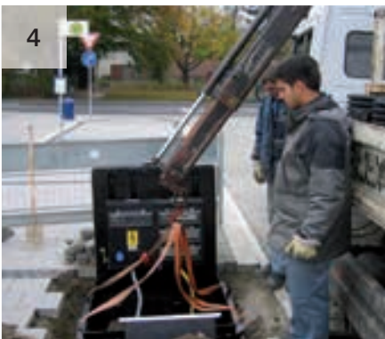
Inserimento del Campetto nello scavo preparato.
