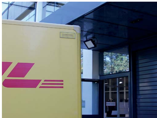
Illuminazione tettoia con AlphaLUX
